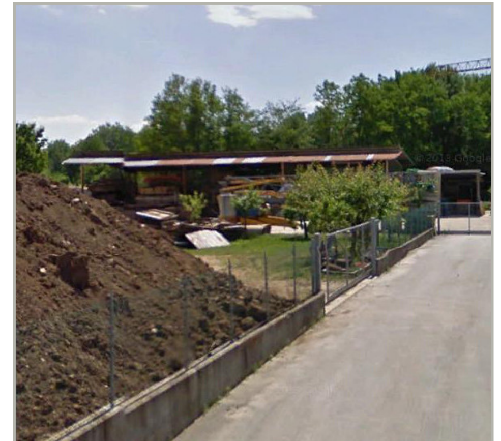
Documentazione fotografica (edificio da demolire, Lato Nord)
