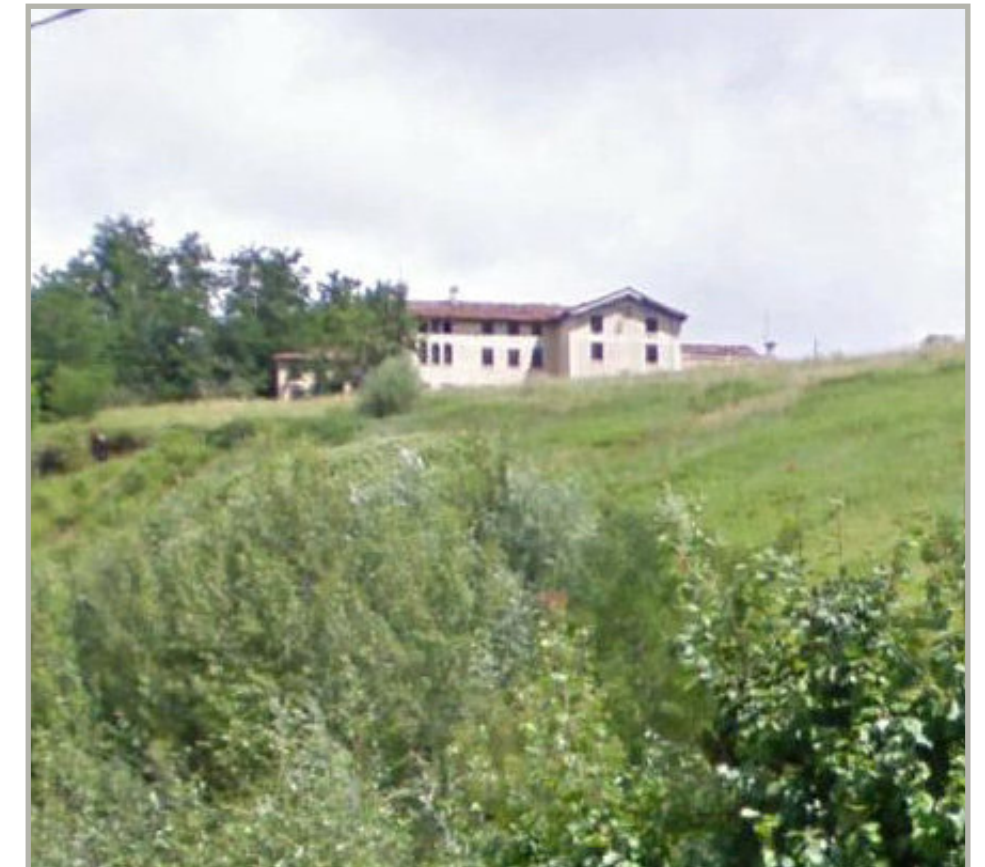
Documentazione fotografica (panoramica edificio, Lato Sud)
