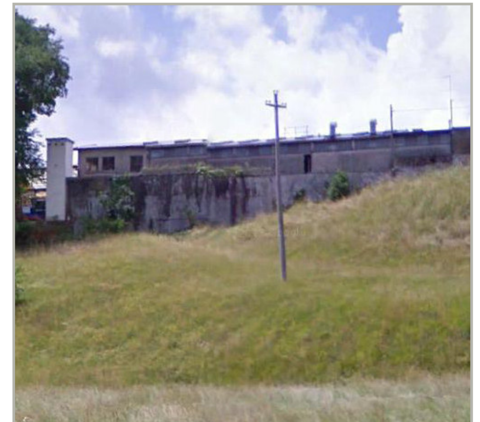
Documentazione fotografica (edificio da demolire, Lato Nord)
