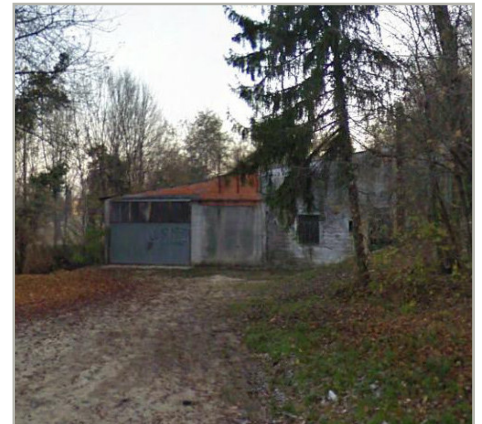
Documentazione fotografica (edificio da demolire, Lato Sud)
