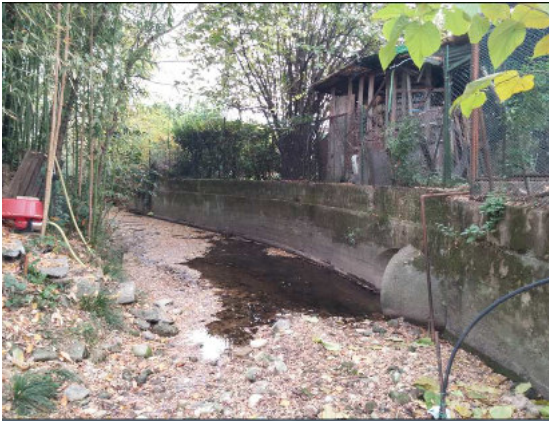
Scolmatore all'inizio di via de Gasperi
