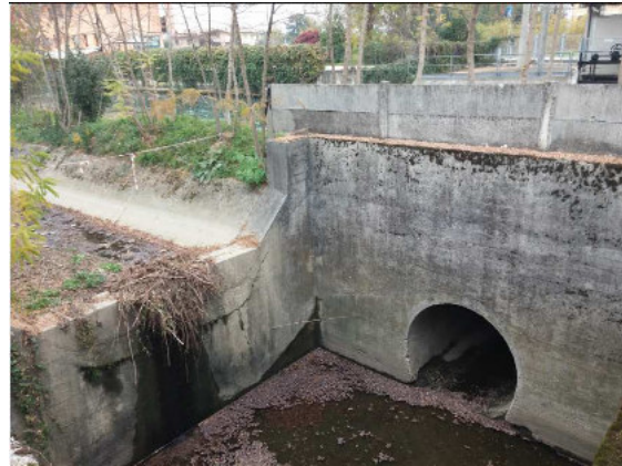
Attraverso del torrente Nasson del Canale Asolo-Maser
