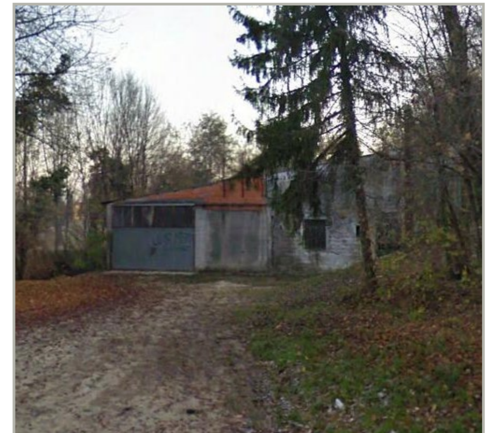
Documentazione fotografica (edificio da demolire, Lato Sud)
