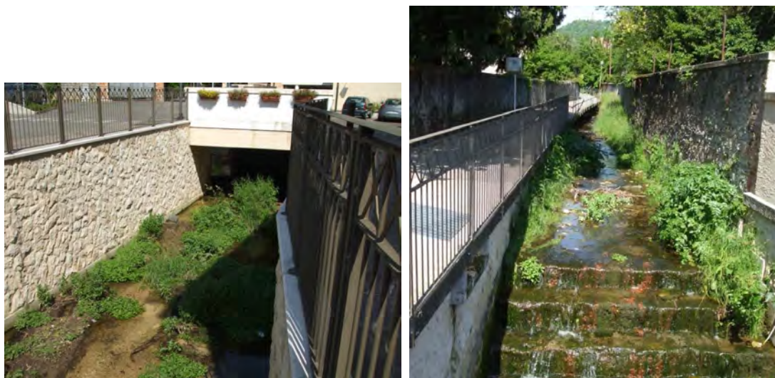
Il Ru Bianco nel tratto di attraversamento del centro abitato
