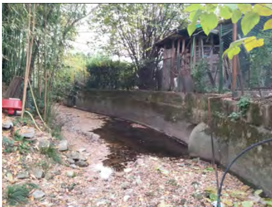
Scolmatore all'inizio di via de Gasperi
