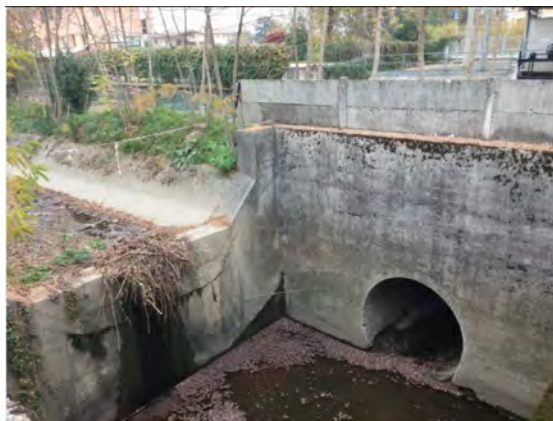
Attraverso del torrente Nasson del Canale Asolo-Maser
