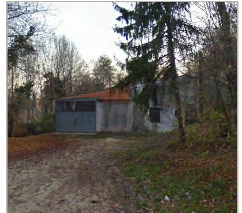
Documentazione fotografica (edificio da demolire, Lato Sud)
