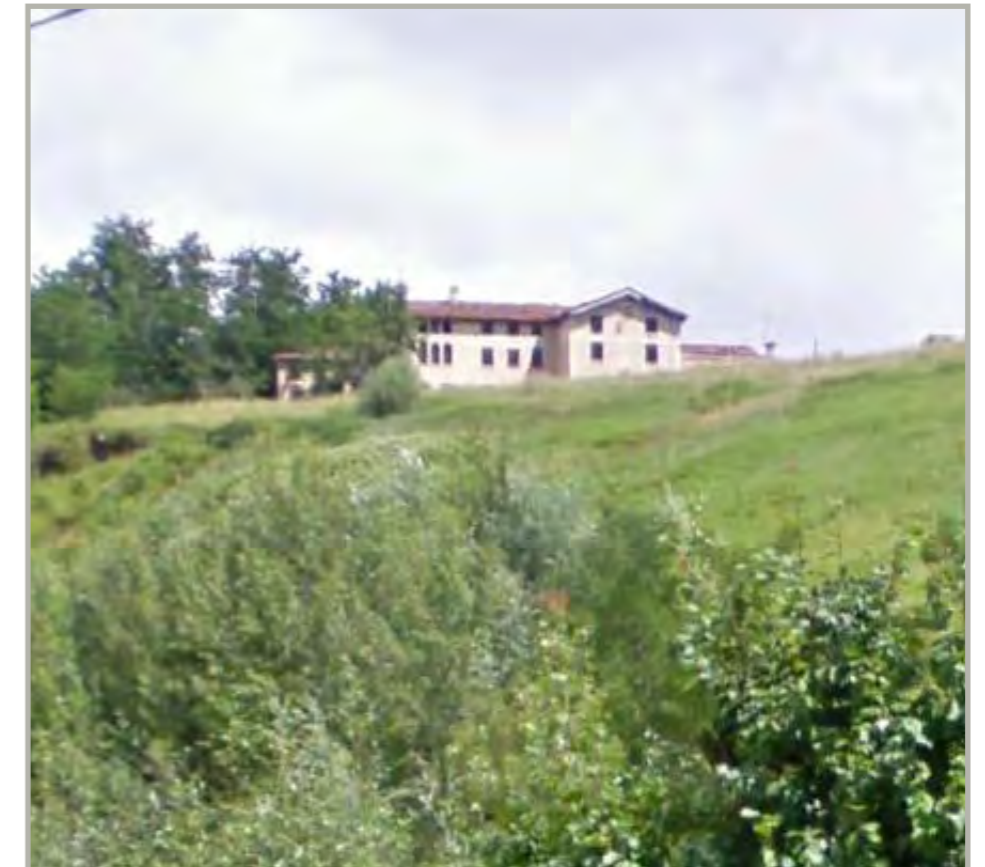
Documentazione fotografica (panoramica edificio, Lato Sud)
