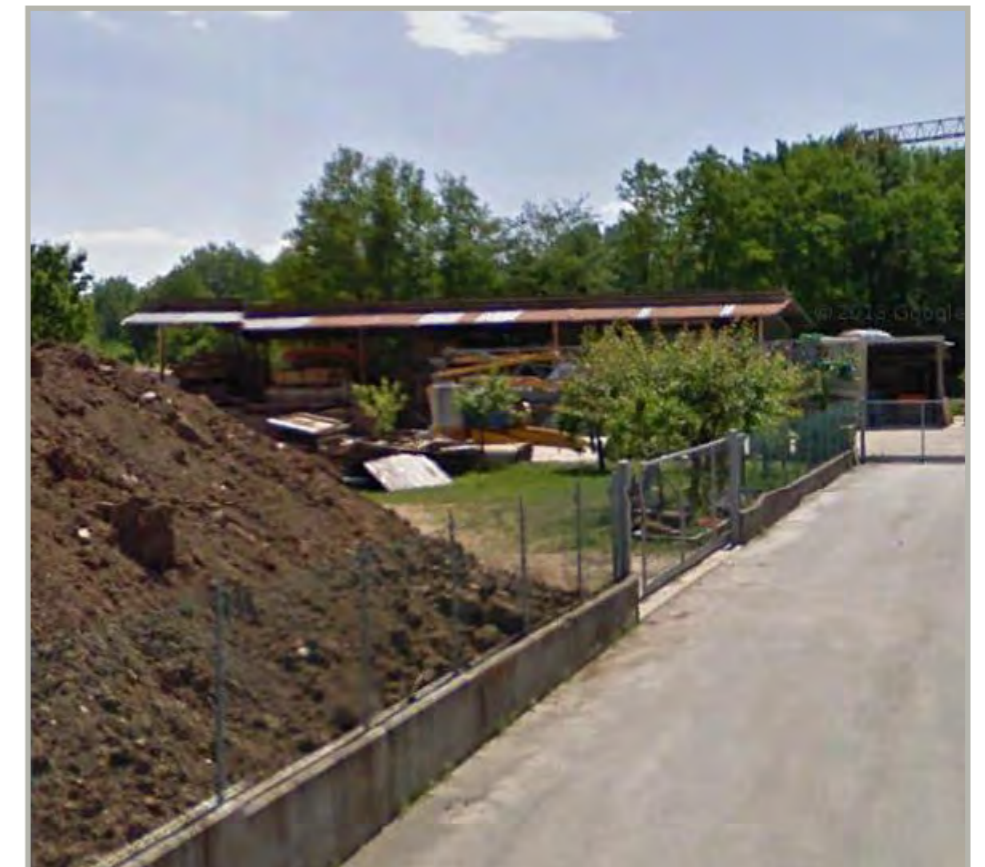
Documentazione fotografica (edificio da demolire, Lato Nord)
