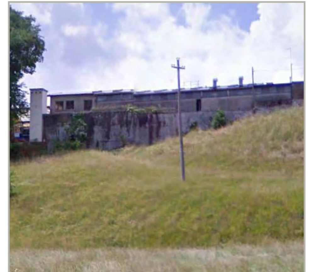
Documentazione fotografica (edificio da demolire, Lato Nord)
