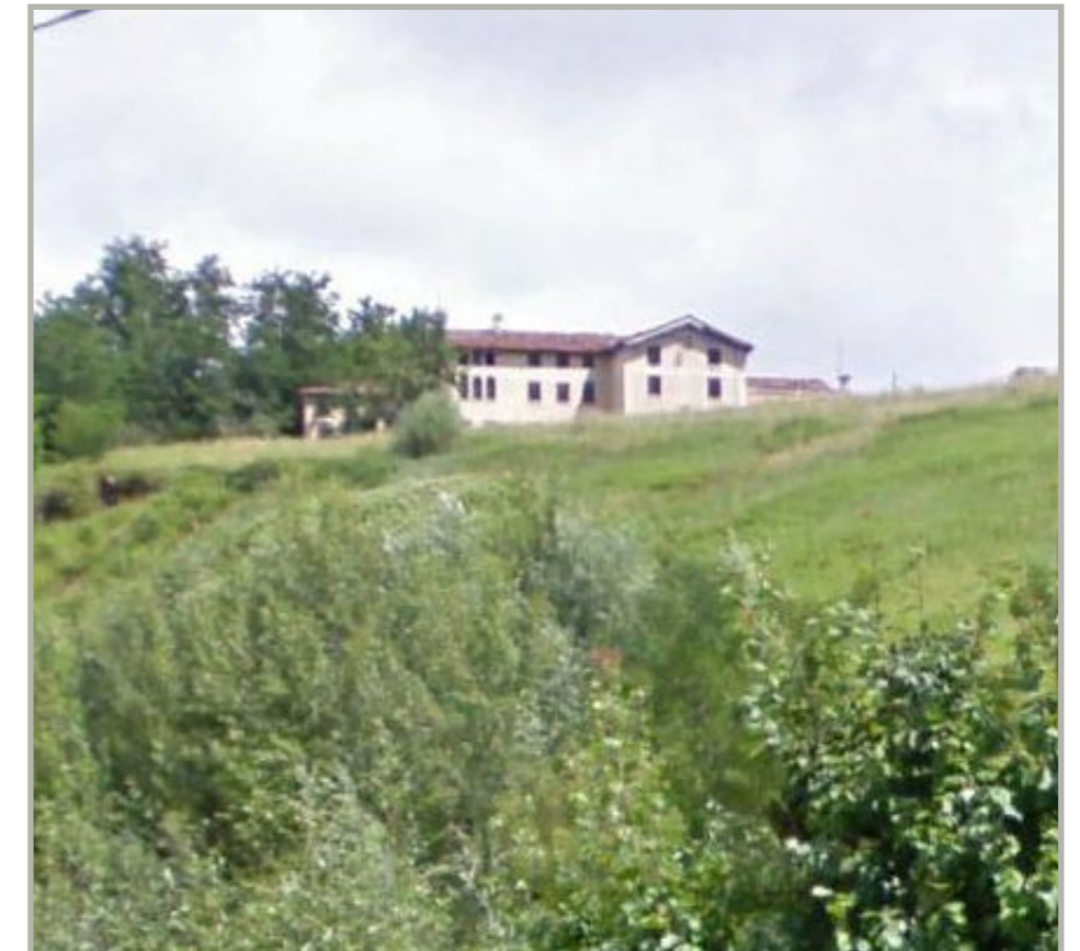
Documentazione fotografica (panoramica edificio, Lato Sud)
