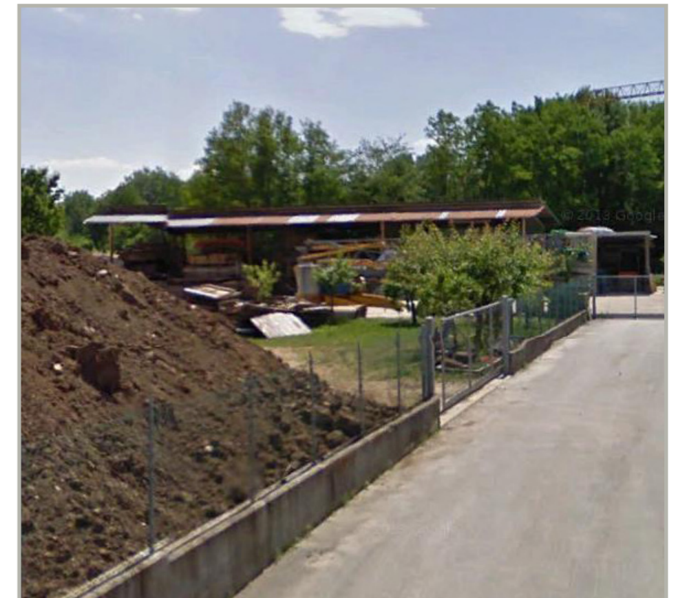
Documentazione fotografica (edificio da demolire, Lato Nord)
