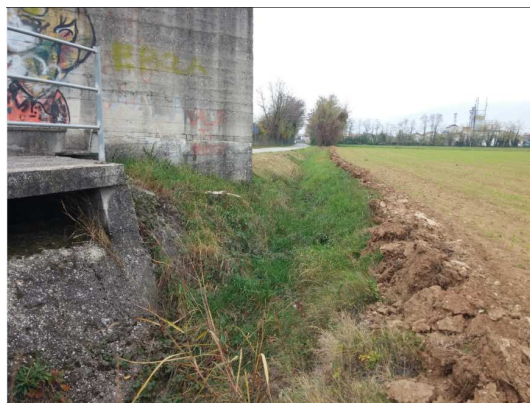
Fosso di guardia di via Antighe nei pressi manufatto condotta Asole-Maser
