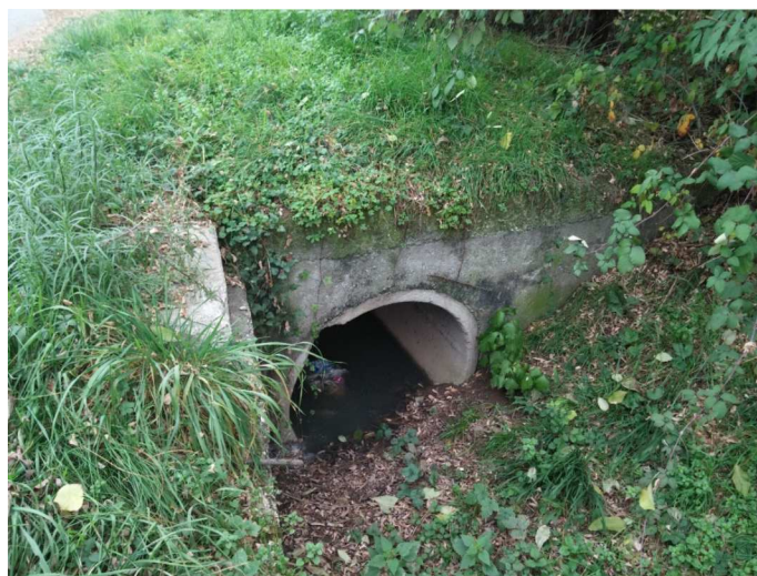
Sfioratore di emergenza del Ru Nero in via Antighe
